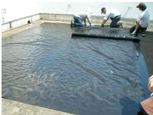
防水シートの敷きこみ
