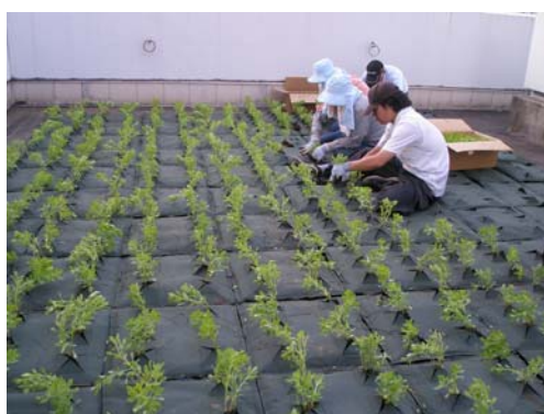
開口部に苗を植付け、紐を締め固定
